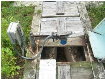
Figure 37: Effluent Flow Meter
